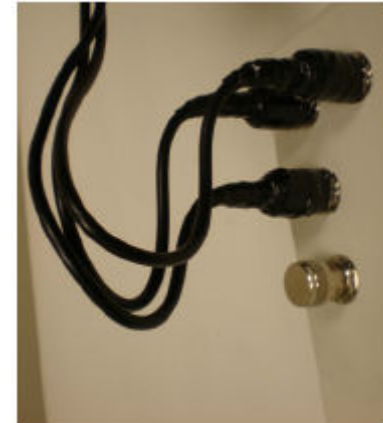
FIGURE 21 Créer des boucles d'égouttement de câbles
