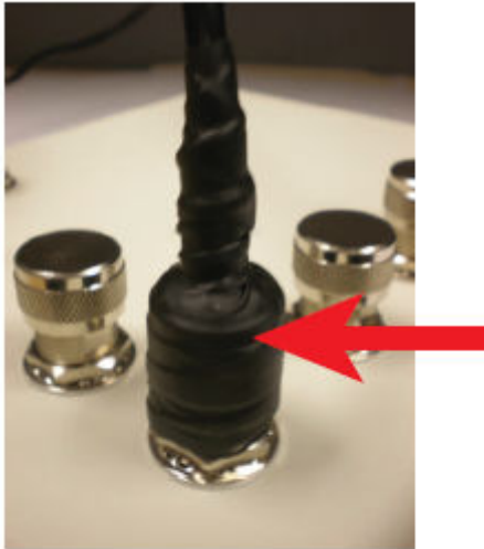
FIGURE 17 Enrouler le ruban d'étanchéité
