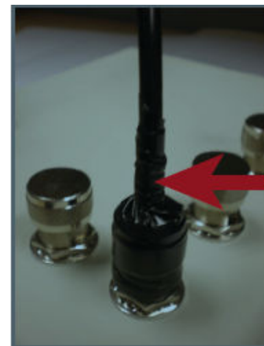
FIGURE 15 Enrouler le ruban isolant
