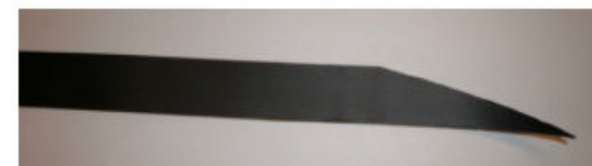
FIGURE 16 Couper le ruban d'étanchéité en angle
