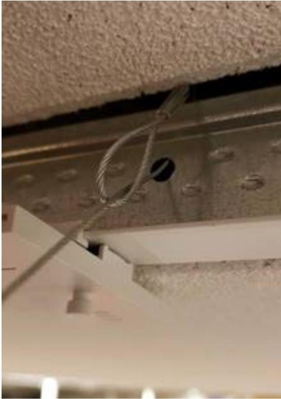
2. Faites descendre le câble de sécurité entre la barre en T et la dalle du plafond.
