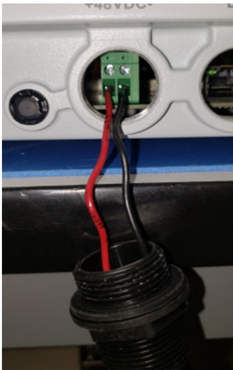
FIGURE 7 Raccordement des fils de courant continu au bornier
